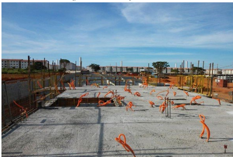
Figura 2: Vista da laje concretada
