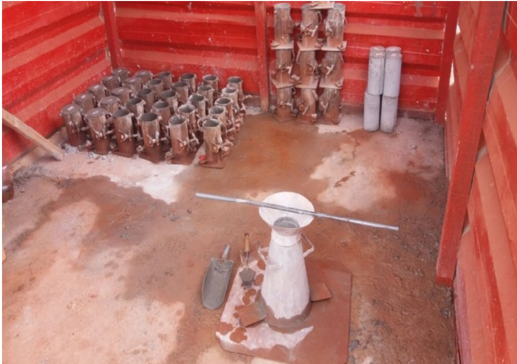
Figura 3: Instrumentos para controle de qualidade no canteiro de obras
