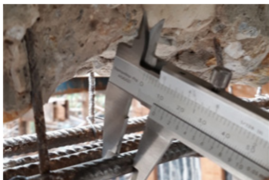
Avaliação da armadura
