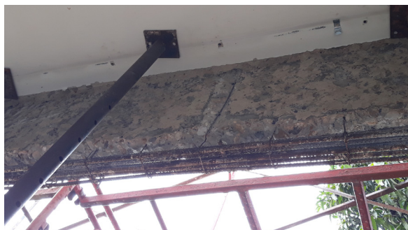
Alta densidade de barras
