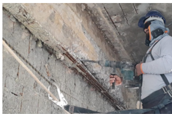
Remoção de concreto nas vigas
