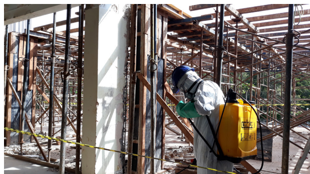
Aplicação do realcalinizante nos pilares
