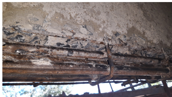
Detalhe após a remoção do concreto
