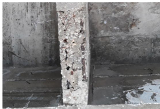
Nichos de concretagem
