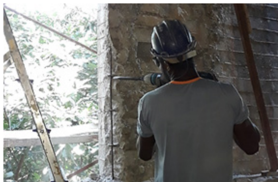
Remoção de concreto nos pilares
