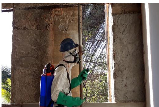
Aplicação do realcalinizante nas vigas
