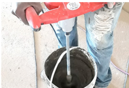
Mistura da argamassa
