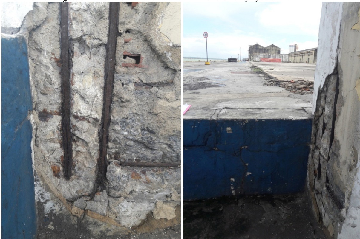
Figura 2: Pilar de concreto armado localizado na zona de spray a 30 m do mar
