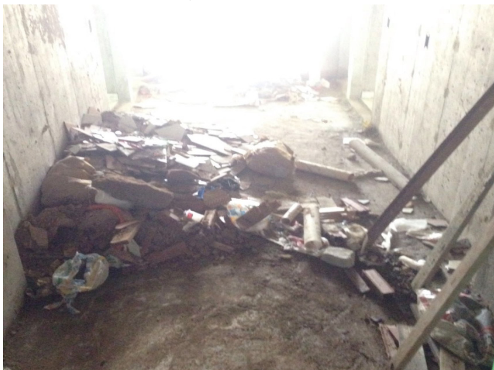
Figura 10: Limpeza de obra
