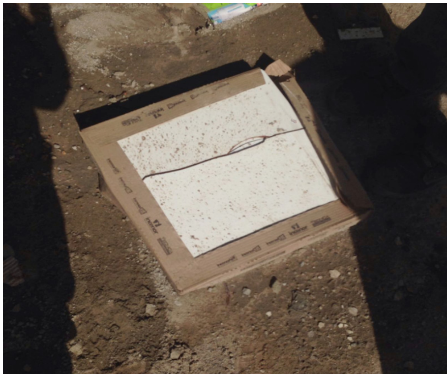
Figura 6: Desperdício de material (revestimento cerâmico)
