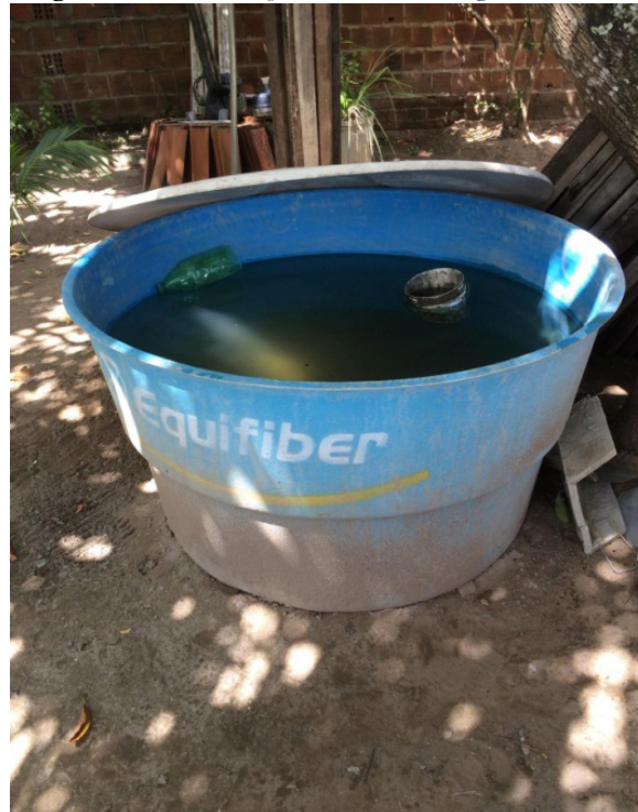
Figura 1 - Cisterna para armazenar água da chuva.
