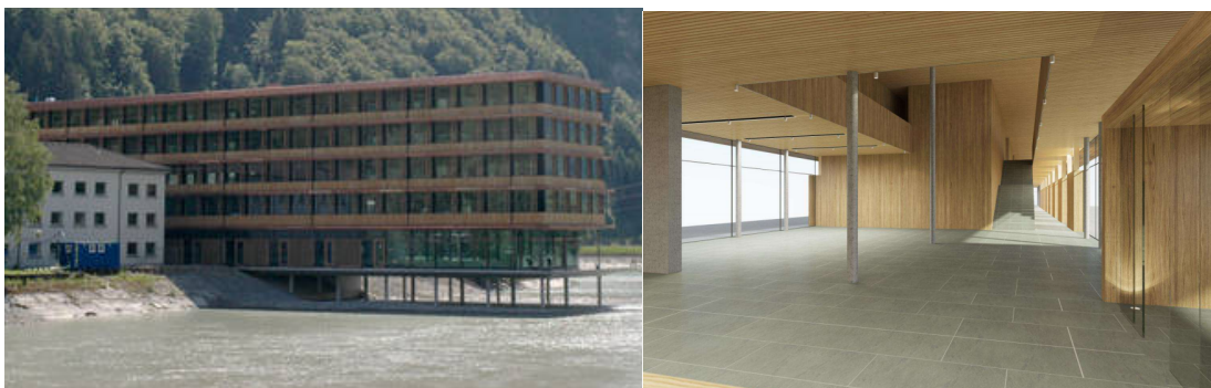
Figura 12 - Vista externa e interna do Escritório da Hidrelétrica Montafon .
