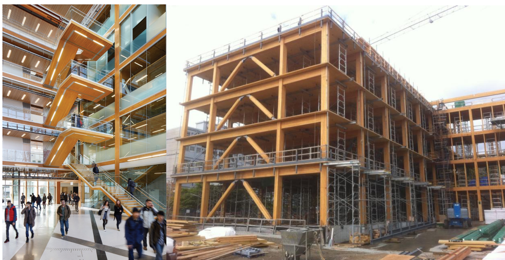
Figura 6 - Vista Interna e foto do processo construtivo do Earth Sciences Building .
