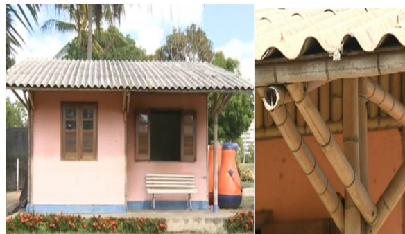
Figura 4 - A- Casa ecológica estruturada em bambu, no Parque Augusto Franco, em Aracaju-SE B- Tesoura de bambu.
