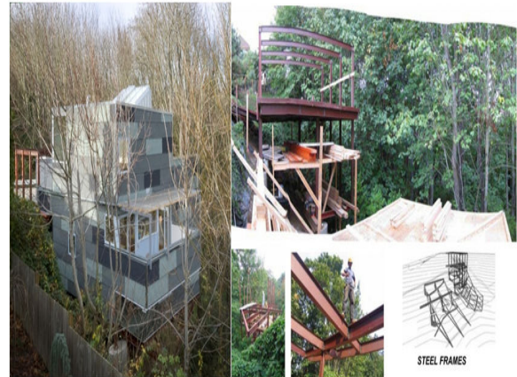
Figura 1 - A : Treehouse em Seattle; B: Esquema estrutural e de montagem Stell frame , durante construção da Treehouse.
