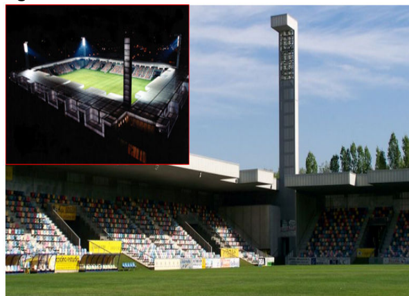
Figura 4 - Interior do estádio
