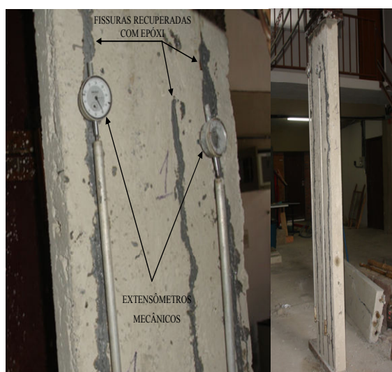
Figura 5 - Painel 1 com fissuras preenchidas com epóxi antes do ensaio
