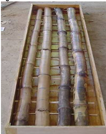
Figura 3 - Colmos de bambu na fôrma
