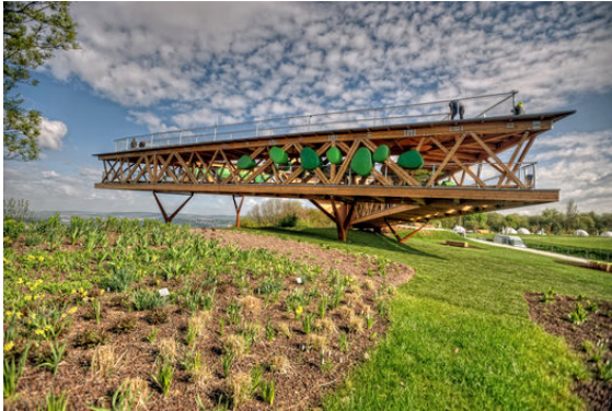
B – Detalhe do acesso à cobertura
